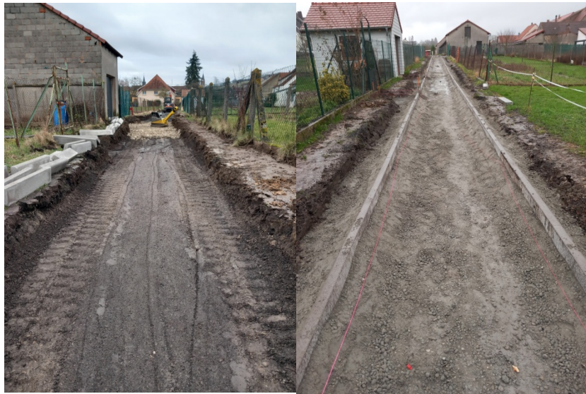
Fig : 8. Vue préparation du chantier et mise place des bordurettes sur le sentier à l'arrière de la rue du stade.
