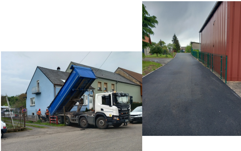
Fig : 12. La pose des enrobés au printemps 2024.
