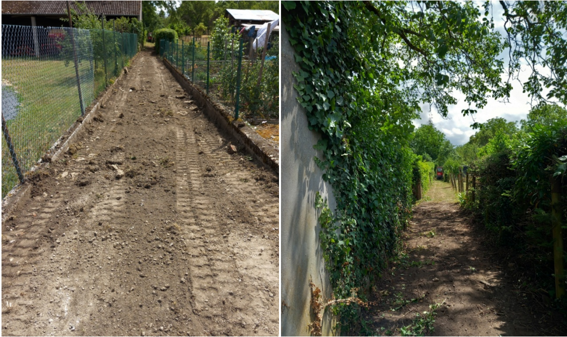
Fig : 6. Début du chantier en 2023 dans le secteur de la venelle à l'arrière de la rue de mairie
