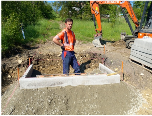
Fig : 15. Vue de la mise en place des pas d'âne.
