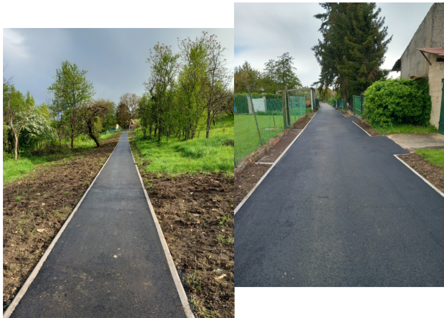
Fig : 13. Vue des sentiers avec enrobé secteur ouest et secteur nord du tracé.
