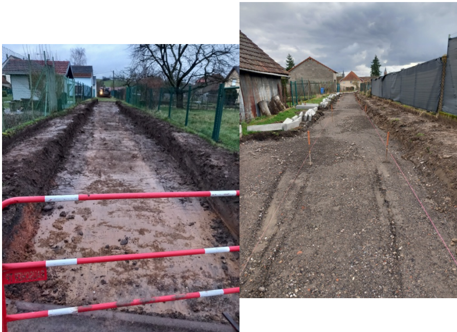
Fig : 7. Décaissement en février 2024 et mise en concassé du sentier secteur arrière rue du stade.
