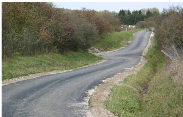
L'Association foncière a décidé d'engager de conséquents travaux de réfection de plusieurs chemins d'exploitation. Afin de garantir une meilleure efficacité à ces travaux et une résistance plus importante dans la durée, la mise en œuvre d'enrobés denses à chaud est privilégiée afin de limiter les phénomènes d'érosion en cas de fortes pluies sur les bassins versants.
