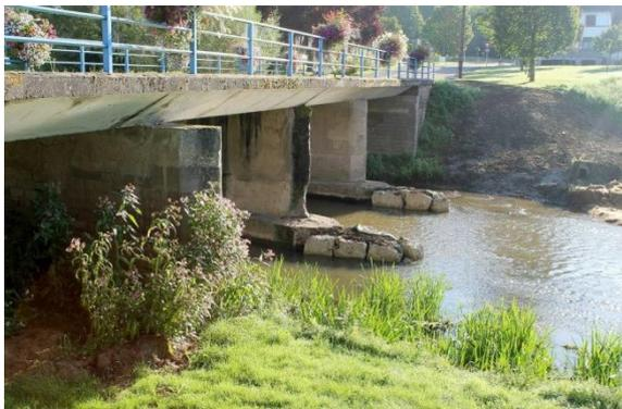
Profitant de la présence des engins de chantier, la troisième arche du pont de la « Seelwies » a été dégagée pour faciliter les écoulements en cas de forte pluie.
